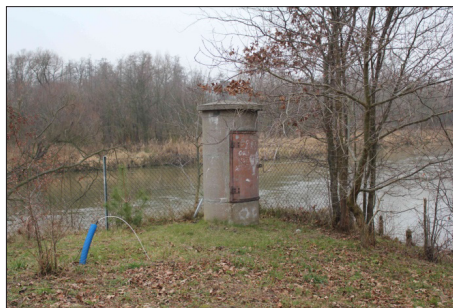
Fot. 2. Wieża limnigraficzna przy wejściu do portu nadzoru wodnego (fot. M. Gorączko)
